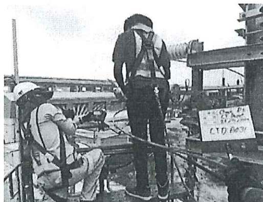
รูปที่ 3-10 การตรวจสอบค่าความต้านทานของฉนวน
