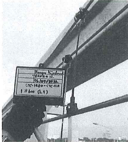
รูปที่ 3-20 การตรวจสอบตำแหน่งแฮงเกอร์
